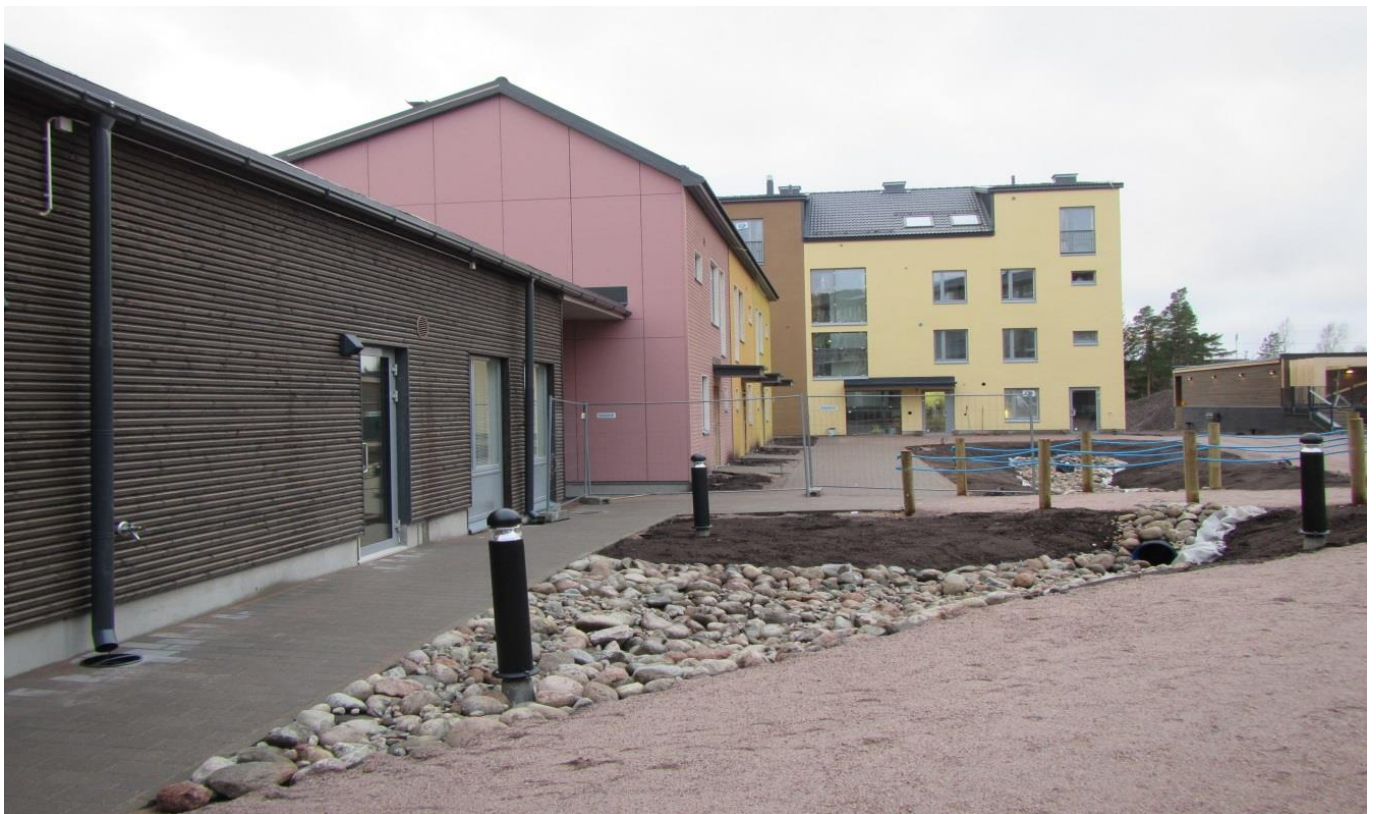
Kuva 16. Rakenteilla oleva hulevesipainanne Kuninkaantammessa joulukuussa 2016. Kuva: Jukka Jormola
