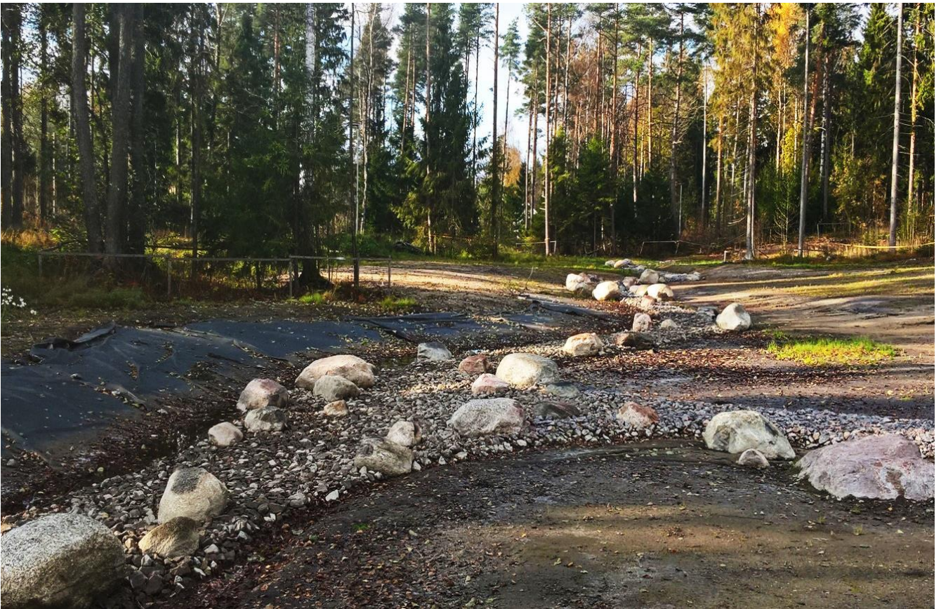
Kuva 17. Hulevesiä kuljettavia painanteita Helen Schjerbeckin puistossa. Kuva: Satu Tyynilä
