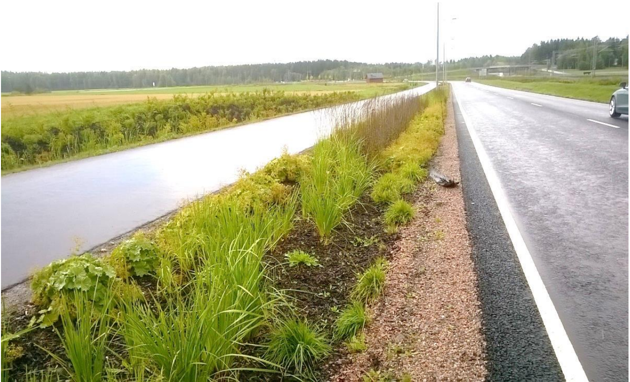
Kuva 11. Tikkurilantien eri tavoin toteutettuja biosuodatusalueita. Kuva: Jukka Jormola
