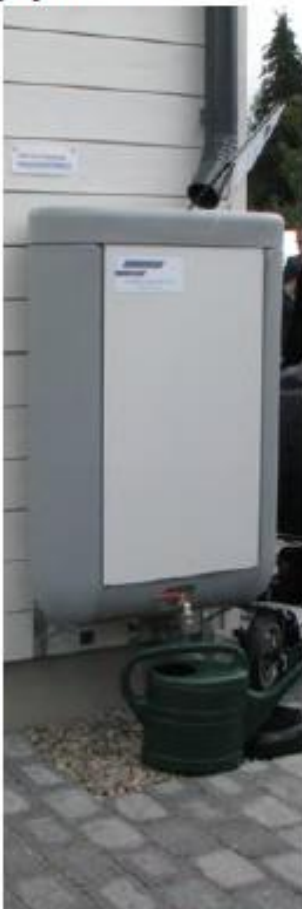
Kuva 4. Hulevesien keräys- ja johtamisesimerkkejä kasvien kasteluun tontilla. Ote Porvoon Kevätlaakson rakentamistapaohjeen liitteestä 8, s.13.
