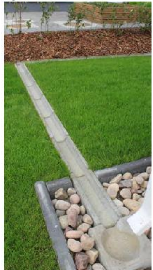
Kuva 4. Hulevesien keräys- ja johtamisesimerkkejä kasvien kasteluun tontilla. Ote Porvoon Kevätlaakson rakentamistapaohjeen liitteestä 8, s.13.
